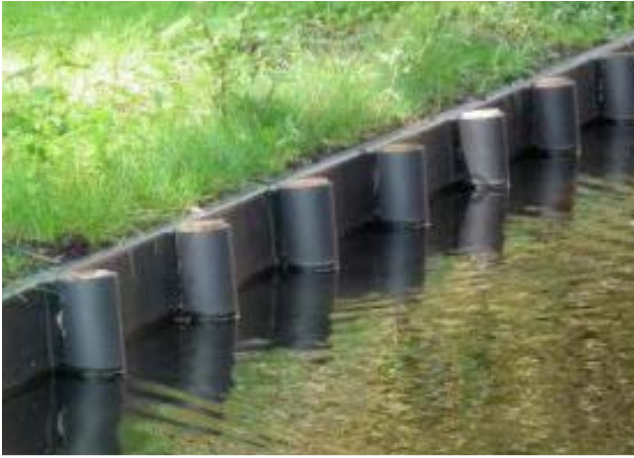
Vb. beschoeiing van gerecycled rubber met hout
