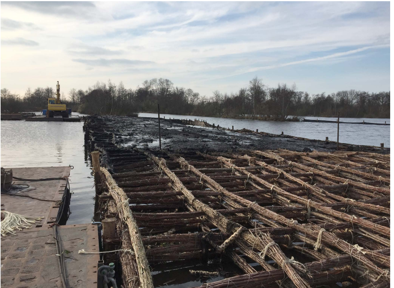
Vb. pilot voor aanleg rieteiland d.m.v. wiepen
